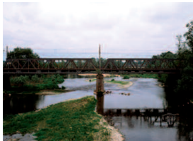
Figure 6-9. Infrastrutture solide: i ponti
