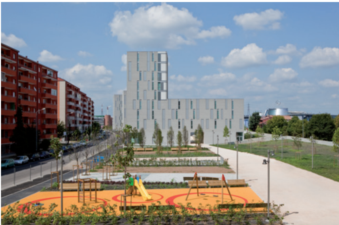
Figura 3. MAB Arquitectura, Abitare a Milano - Via Gallarate (foto P. Riolzi).
